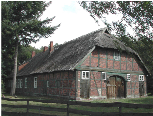
Vierständerhaus in Bohldamm/Neuhaus
